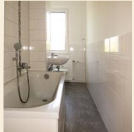
Neben Elektrik, Fußböden und Tapeten werden auch die Bäder erneuert.
