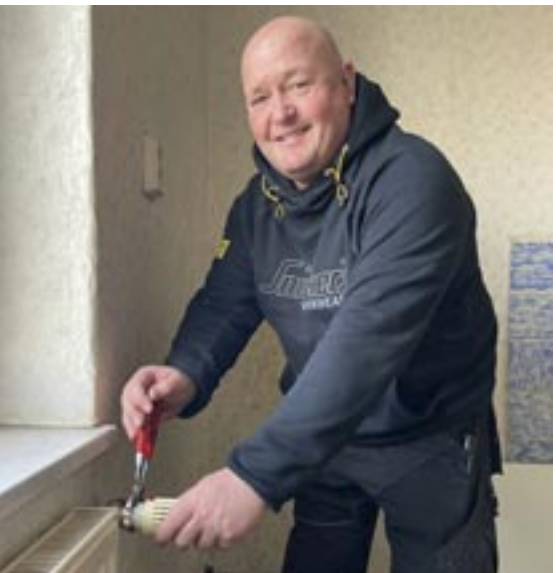
Walter Schwarzenberg beim Wechseln eines Heizungs-Thermostates
